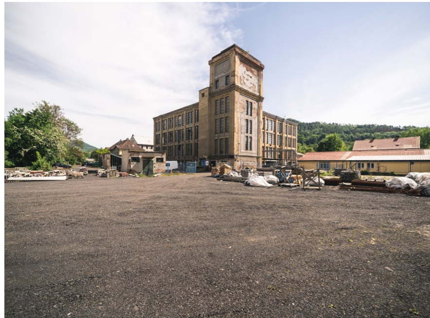
11 Nevyužitá budova bývalé přádelny firmy Theresie Bachheibelové v Děčíně.
