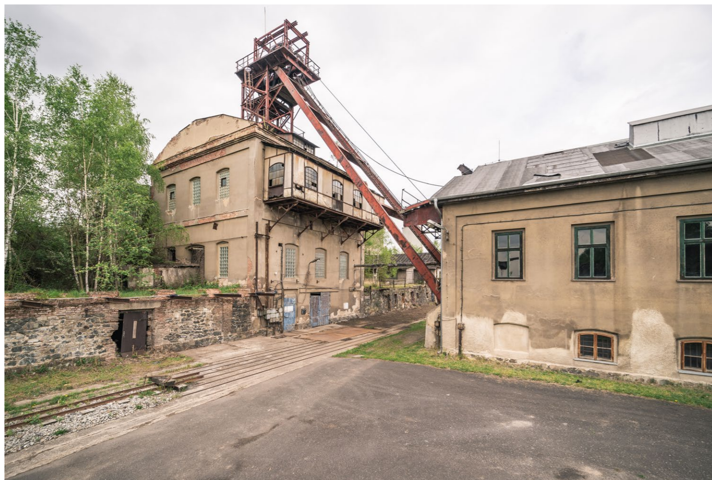
34 Objekty a zařízení dolu Julius byly využity pro expozici Podkrušnohorského technického muzea.
