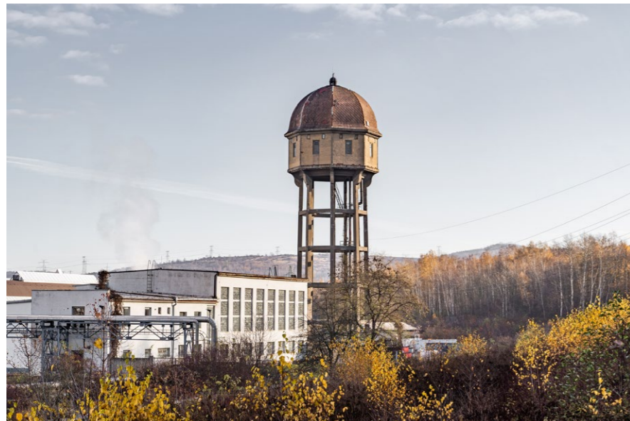
55 Věžový vodojem Bilina, který se nachází v blízkosti trasy Vodobraní.
